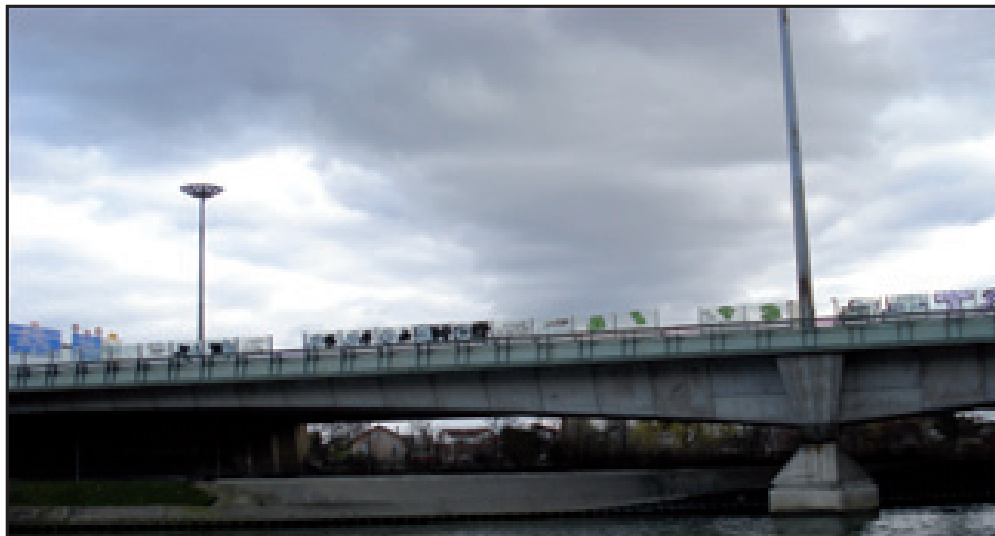
Pont de l'autoroute A4/A86 dans sa traversée de Joinville-le-Pont : sombre avenir pour les riverains et pour l'environnement
